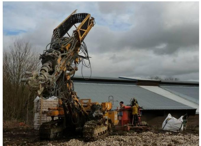
... les pieux eux-mêmes ne sont pas très impressionnants, sauf peut-être quand on imagine qu'ils descendent à plus de 15m de profondeur. Ce ne sont que des tubes d'acier remplis de béton, et doublés ici (du fait de la nature particulièrement défavorable du sol) sur quelques deux mètres de profondeur d'un manchon en PVC lui aussi bétonné.
